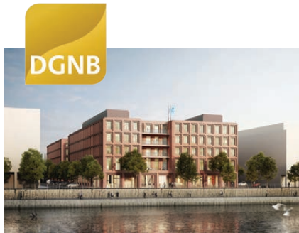
Investitionsbank Schleswig-Holstein, Kiel, Verwaltungsgebäude
