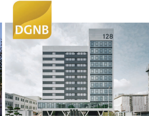
Daimler AG, Stuttgart Bürogebäude 128
