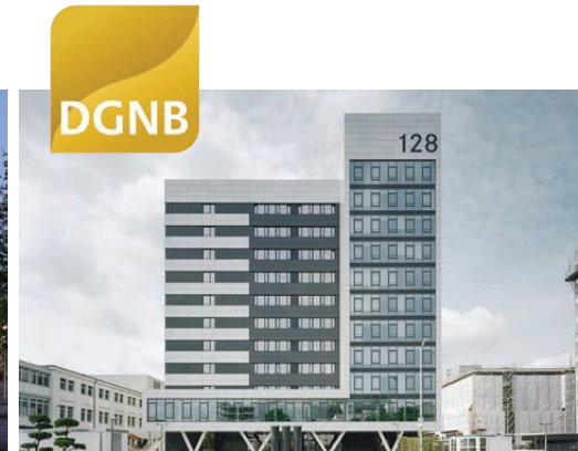
Daimler AG, Stuttgart Bürogebäude 128
